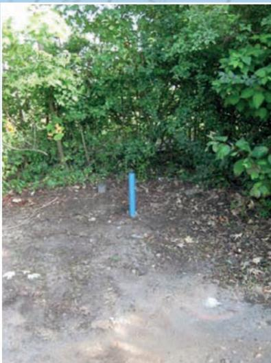
Abb. 2: neu errichtete Grundwassermessstelle
