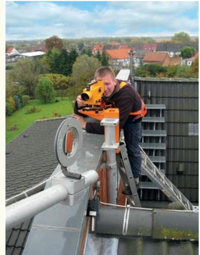
Bestimmung der Höhe einer Referenzstation im Amtlichen Bezugssystem
